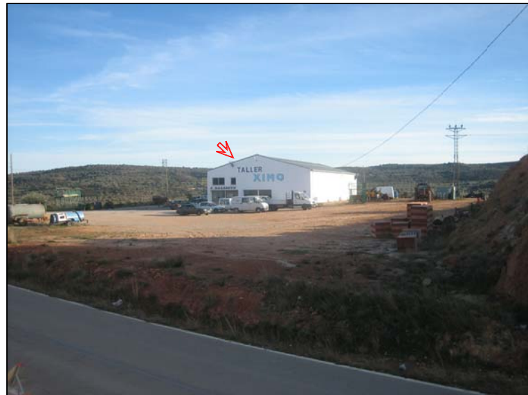
1.- INSTALACIÓN DESDE AVDA. MAESTRAT (OESTE)
