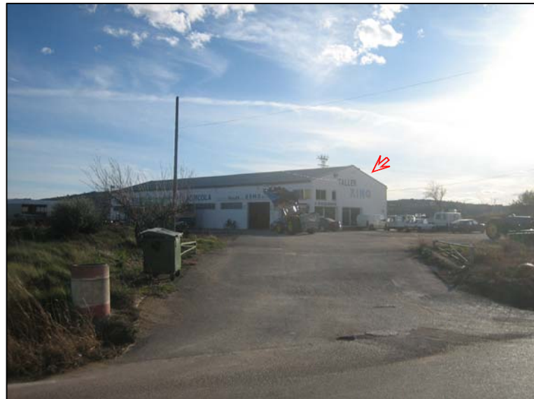
2.- INSTALACIÓN DESDE AVDA. MAESTRAT (ACCESO)
